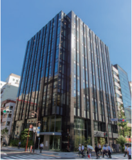
八洲電機 本社ビル
